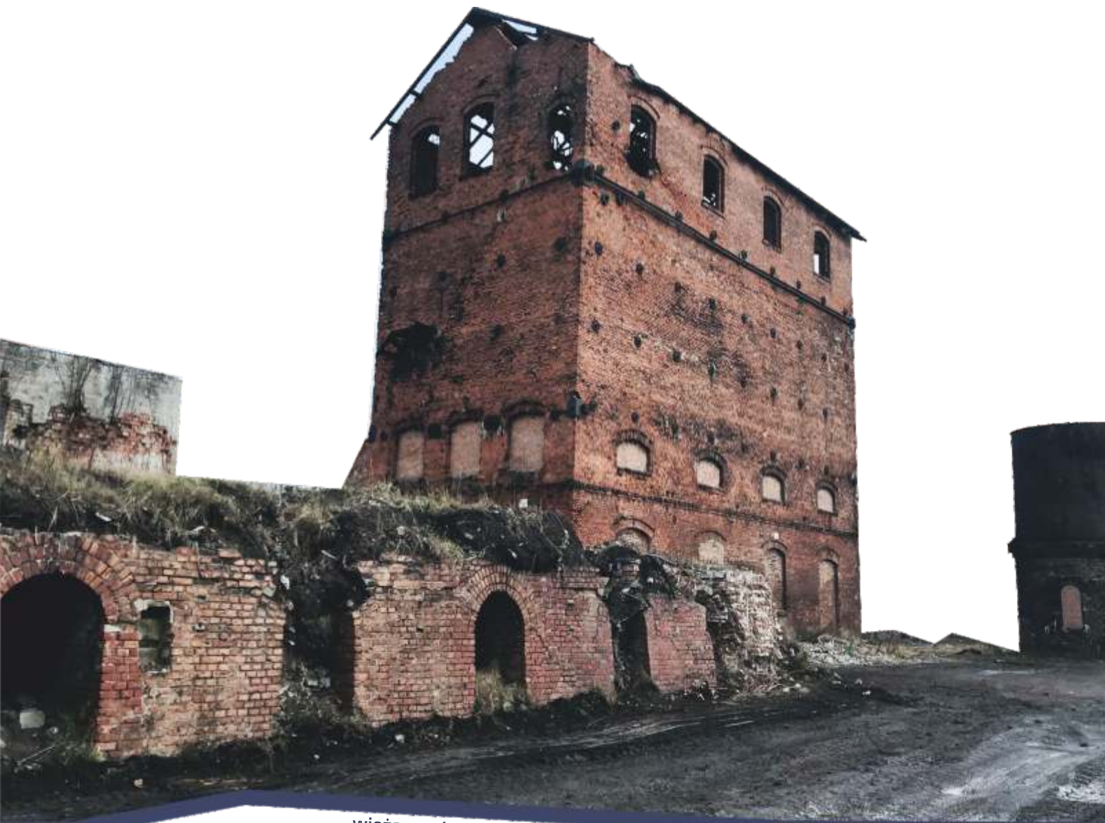
wieża węglowa 2018 coal tower 2018
