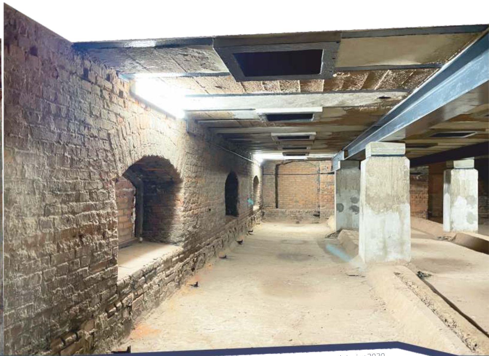
wieża węglowa - wnętrze 2020 coal tower - interior 2020
