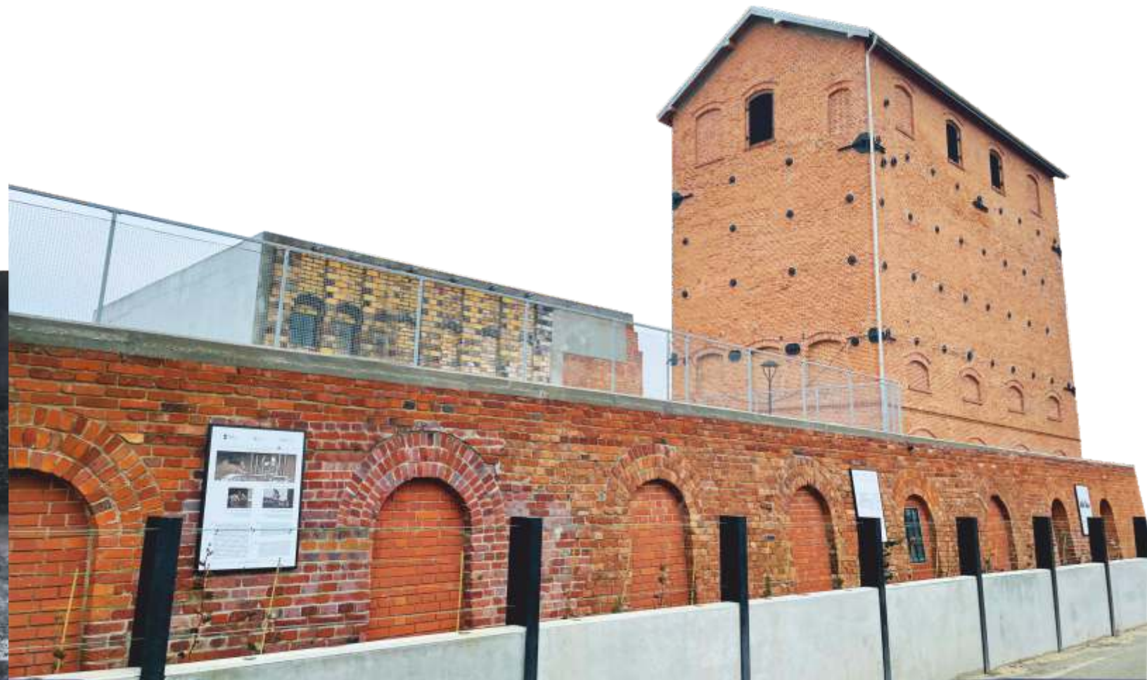
wieża węglowa 2020 coal tower 2020
