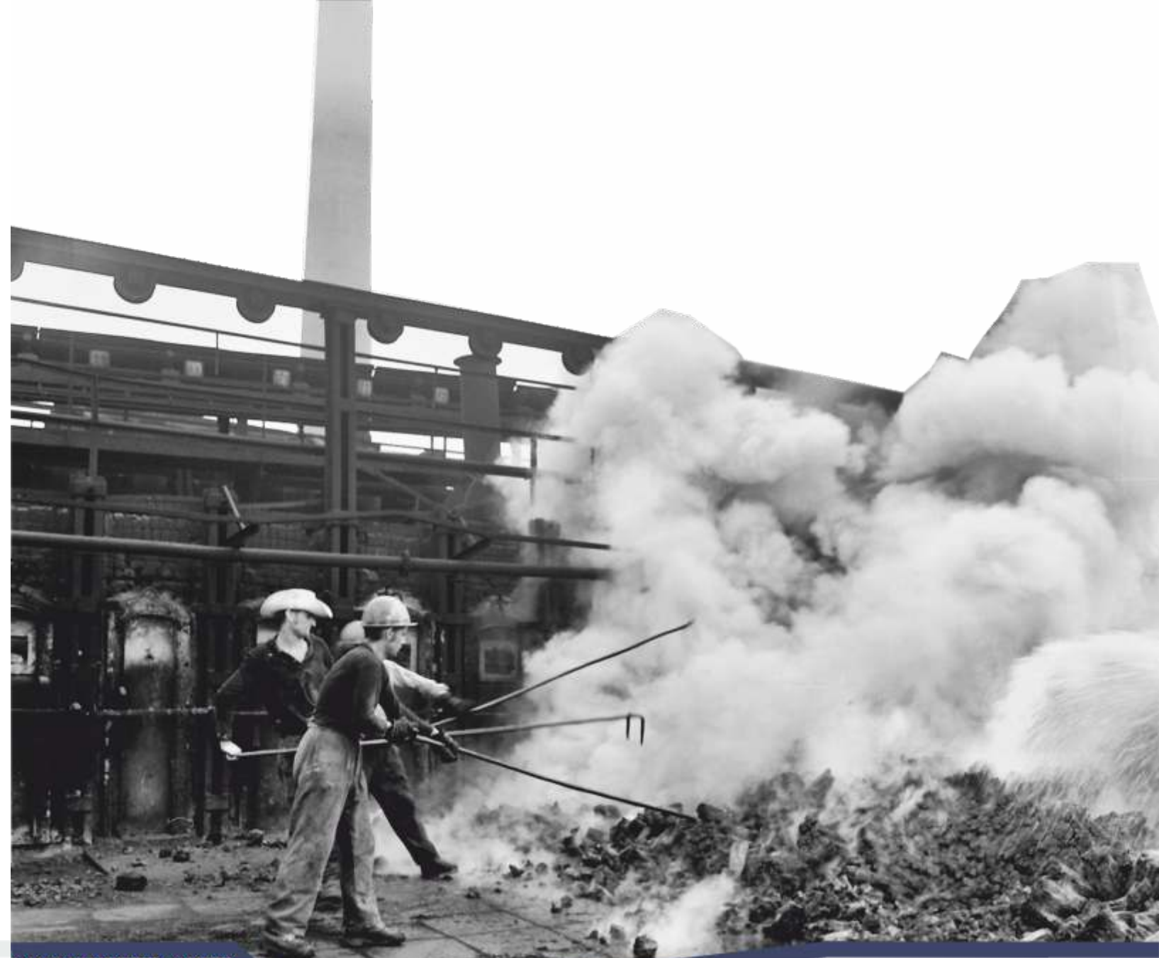
ręczne rozbijanie koksu manual breakdown of coke
