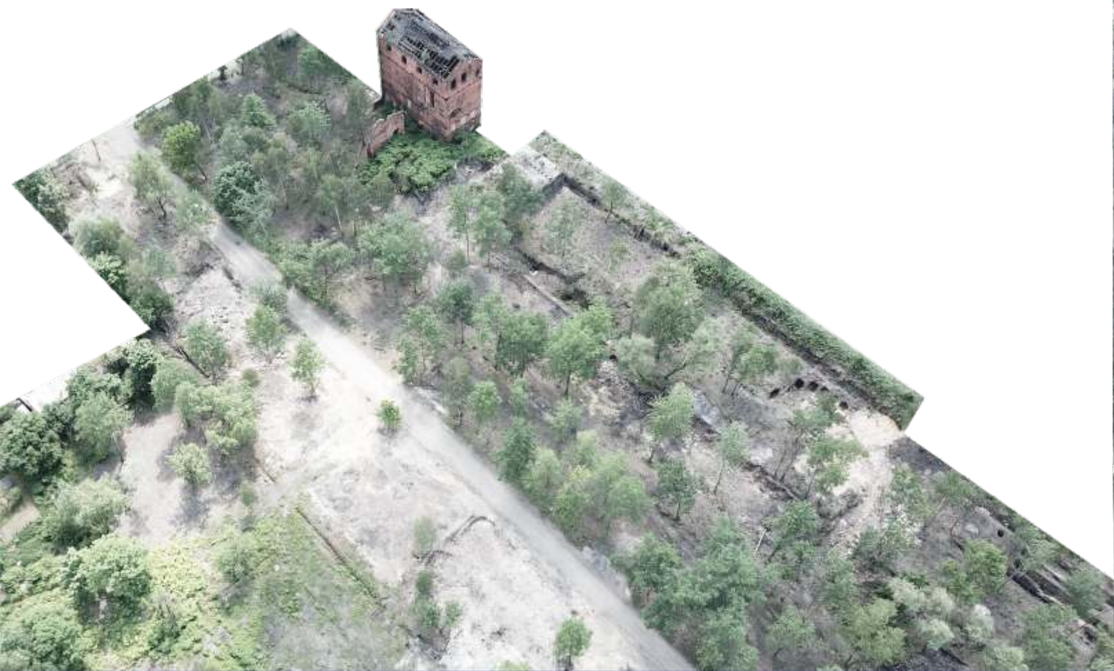
koksownia „Orzegów” 2018 "Orzegów" coke plant 2018
