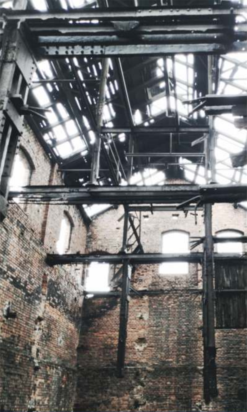
wieża węglowa - wnętrze 2018 coal tower - interior 2018
