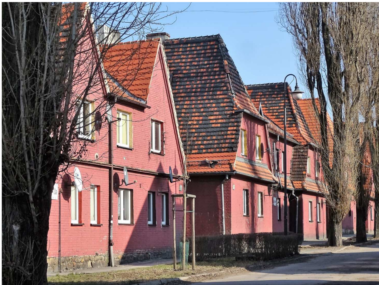
Kolonia robotnicza ul. S. Staszica, Kościelna, H. Wieniawskiego, ul. S. Staszica 10, 8 (IK)
