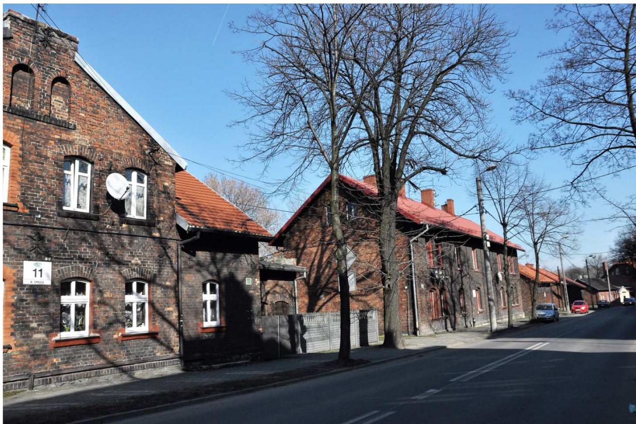
Zabudowa mieszkaniowa ul. R. Sprusa 11, 9 (IK)
