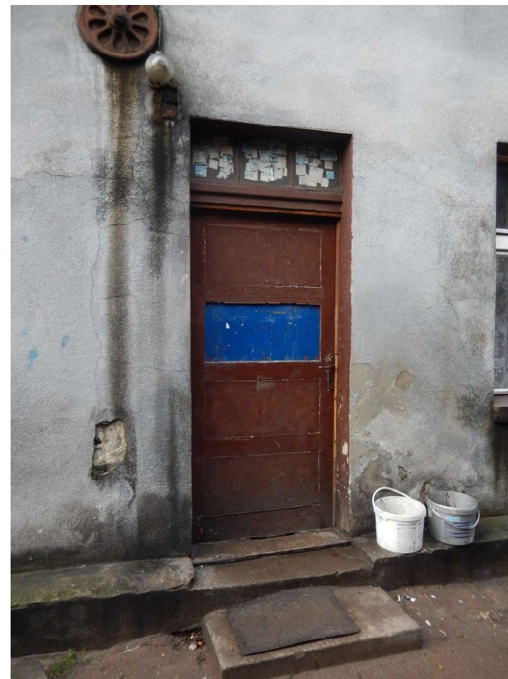
Drzwi wejściowe na elewacji bocznej
