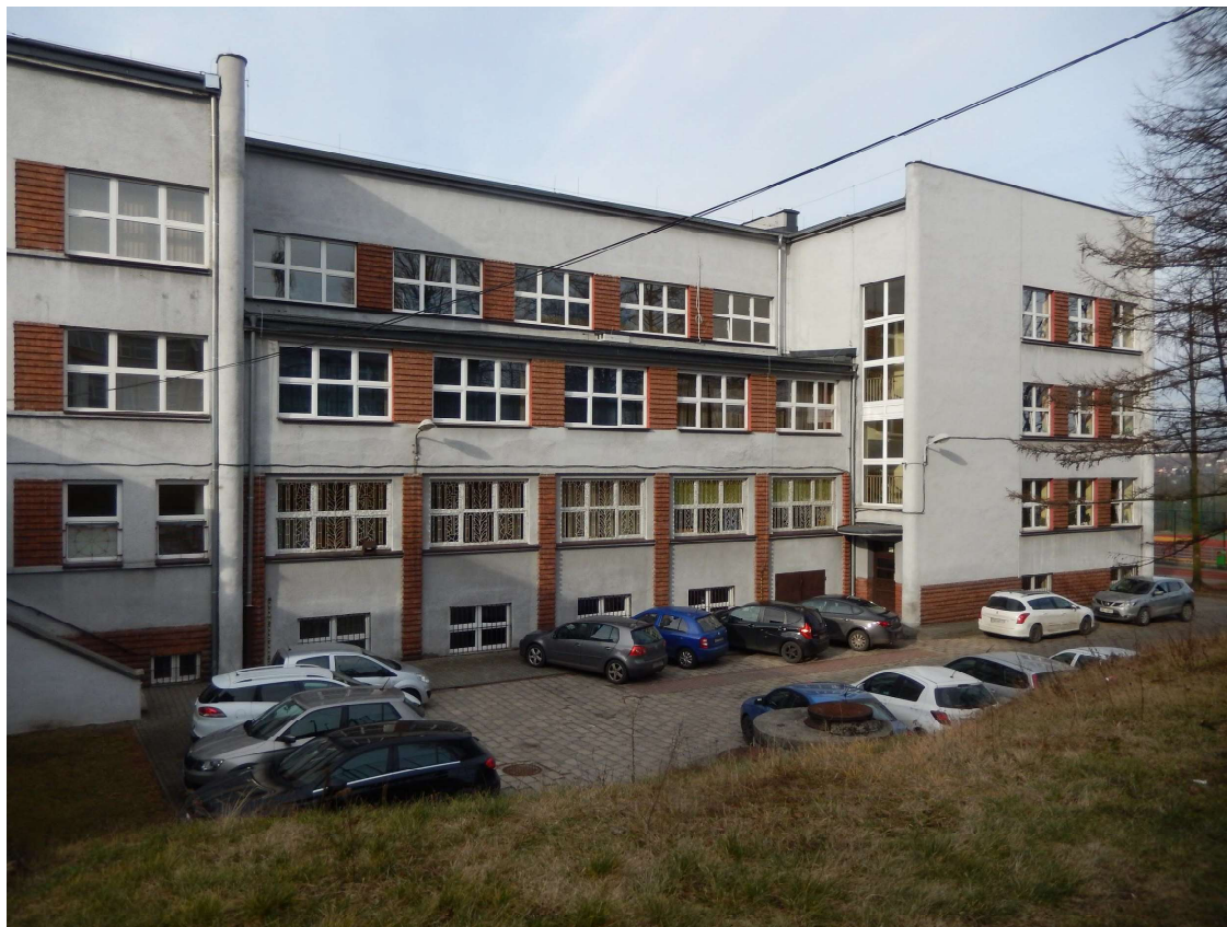
Elewacja tylna oraz fragment głównej klatki schodowej
