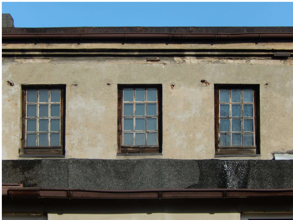
Elewacja tylna - stolarka okienna
