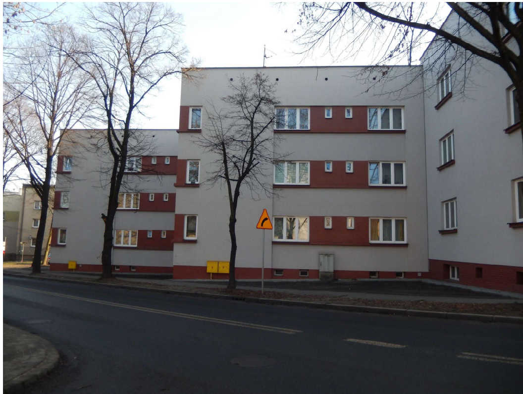
Elewacja frontowa i historyczne zwieńczenie dachu elewacji tylnej
