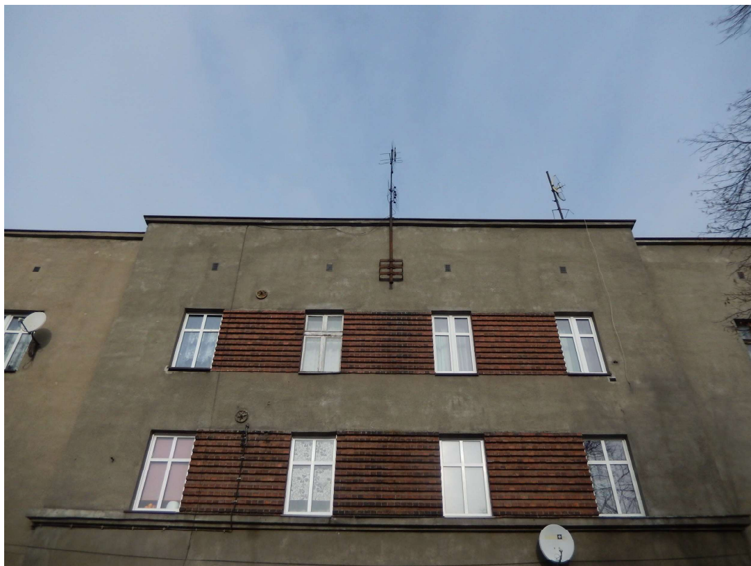
Detale elewacji frontowej
