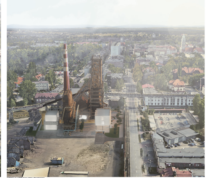
WIDOK W KIERUNKU POŁUDNIOWYM
